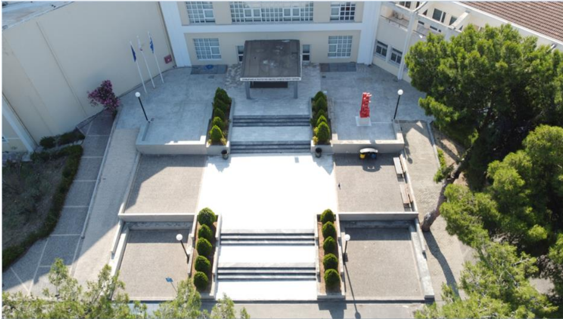
Εικόνα 11. Υφιστάμενη κατάσταση στην κεντρική είσοδο του Συνεδριακού Κέντρου
